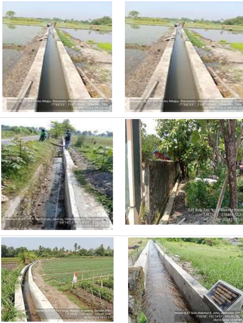
Gambar III. 53 Rehabilitasi Jaringan Irigasi Tersier (PIK)
